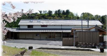
草枕交流館(同館提供)
