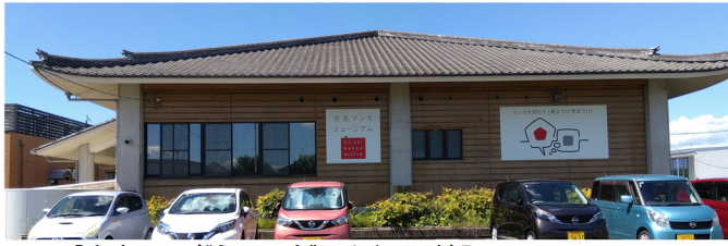
「合志マンガミュージアム」の外観。 内部は熊本県産木材がふんだんに使用されている
